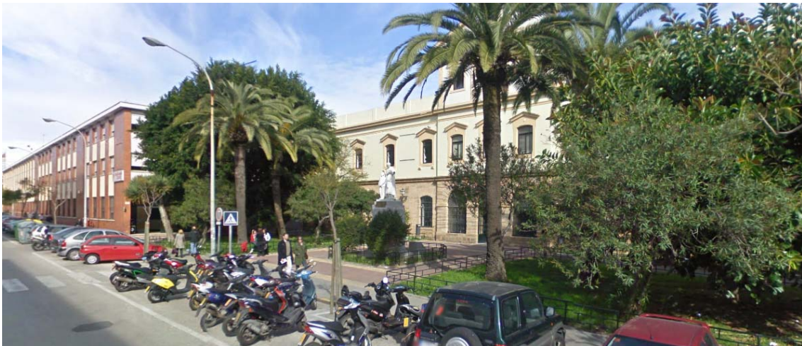
Fachada principal del colegio.
